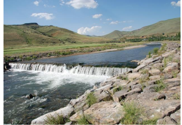
Şekil 6. Ilıca Çayı üzerinde balık geçişlerine engel olan basamaklar Figure 6. The barriers on Ilıca Stream in which blocked fish passage
