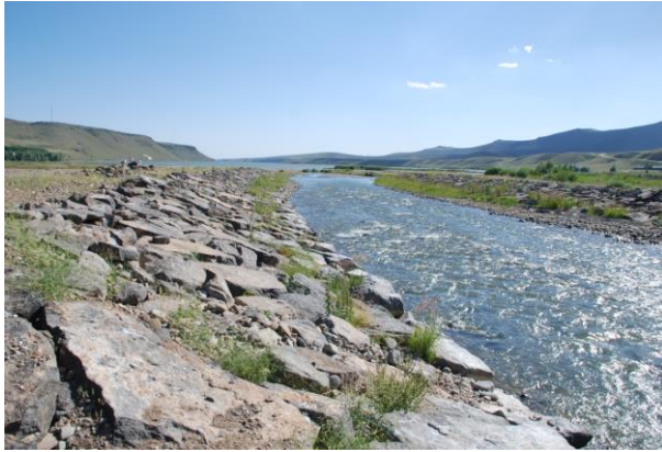
Şekil 5. Kanal haline getirilmiş bir dere yatağı (Ilıca Çayı) Figure 5. Channeled a stream bed (Ilıca stream)
