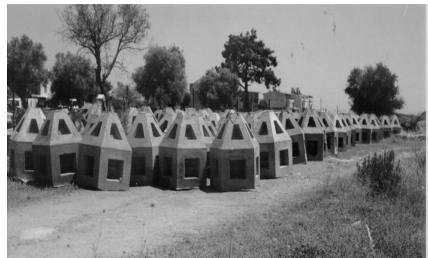
Şekil 2. Gümöldür'de kullanılan beşgen-kubbe şekilli beton resif blokları.
